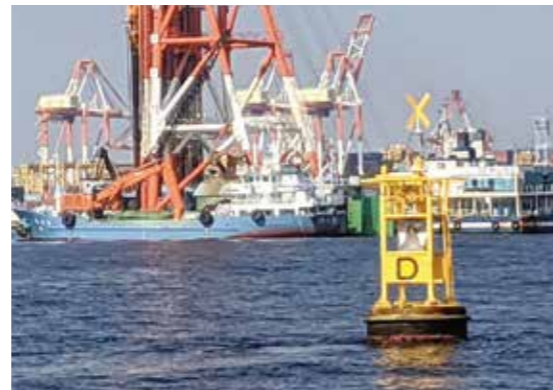
▲ 工事区域を示すブイと荷役中のガット船 ※主に499tでAISを搭載していない船が多い
