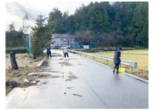
▲ 近所の津波ゴミ撤去(道路啓開)
