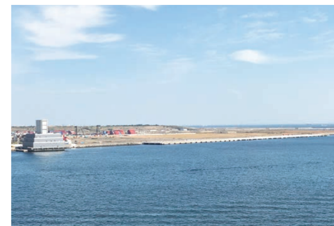
中央防波堤外側コンテナふ頭(現況)
